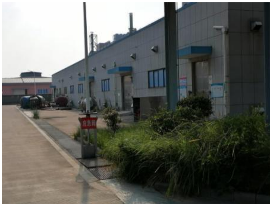
甲类仓库雨水沟新增应急切断阀
