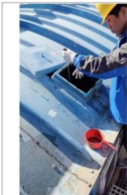
综合废水调节池
