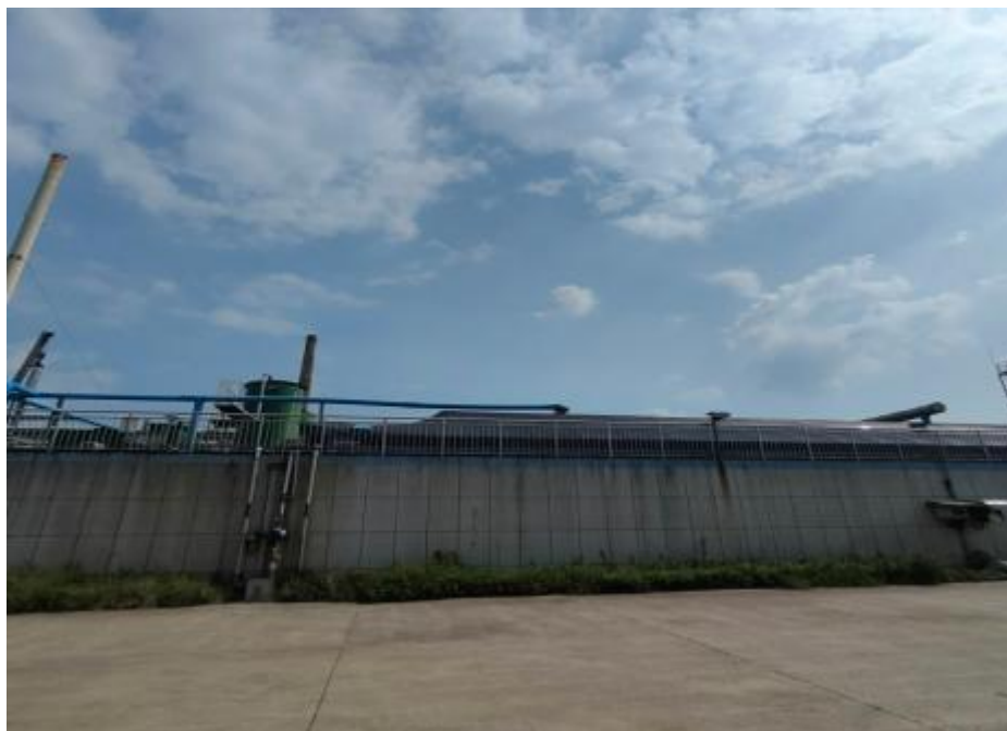
废水治理设施
